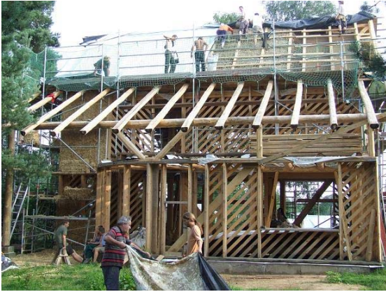
7 pav. Villa Communia pastato stogo apšiltinimo presuotais šiaudais darbai.
